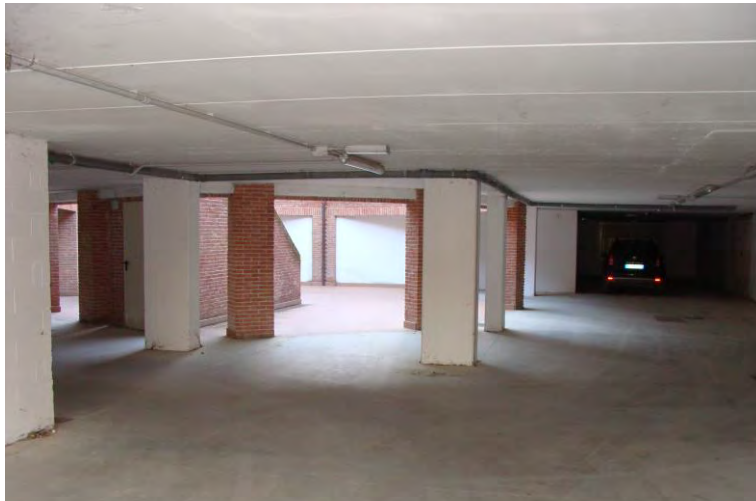
Panoramica garage del complesso immobiliare
