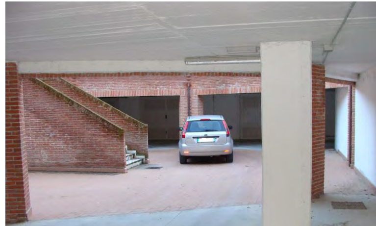
Panoramica garage e spazi comuni a ridosso della scala di collegamento tra il piano primo sottostrada ed il piano terreno del complesso immobiliare
